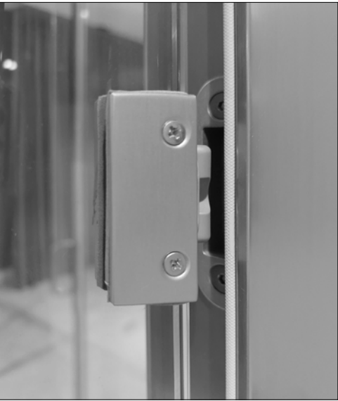
ROSTRO per porta battente vetrata non intelaiata. Evita lo spanciamento del vetro PARROT BEAK LOCK for frameless glazed hinged door. Prevents glass from bowing
